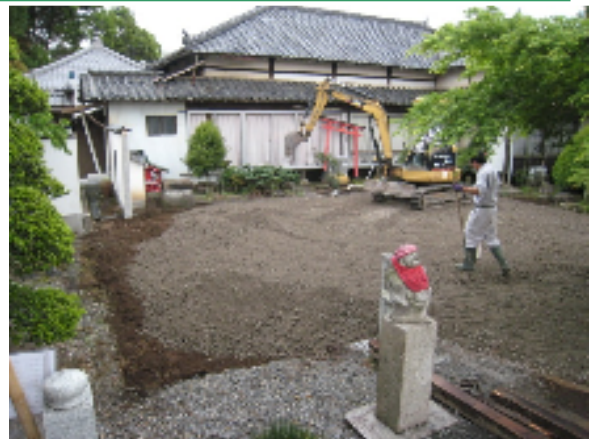
西側と北側の塀を撤去し、ズリを敷いて整地
